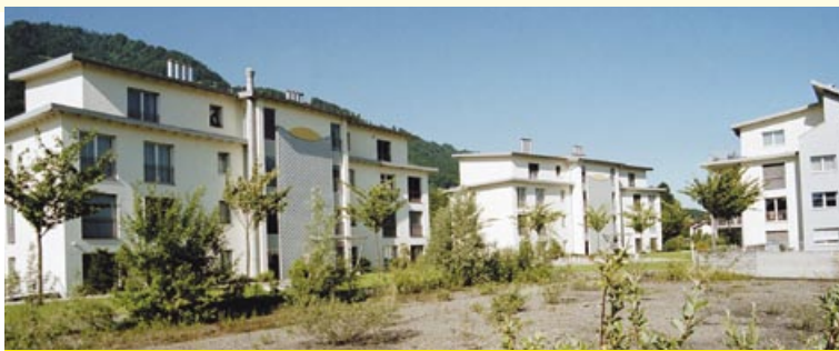
Wohnsiedlung „Chrüzwiess“, Reichenburg
